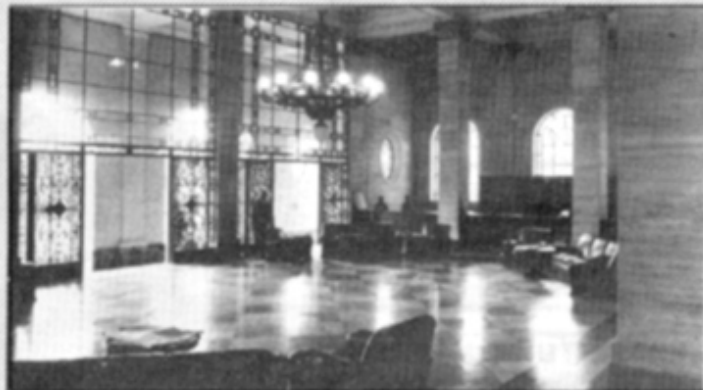
HALL DE ENTRADA - GRANDE HOTEL DE ARAXÁ - 1944 (ARQUIVO SPH/FCCB) - FOTOGRAFIA DOADA PELO AUTOR
